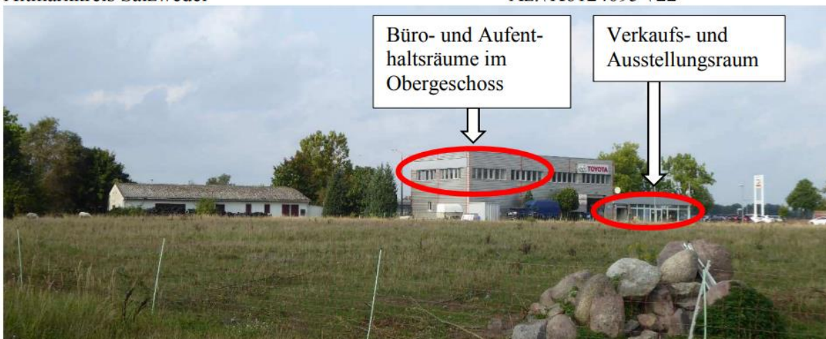
Abbildung 10: Blick auf das Autohaus mit schutzbedürftigen Räumen/Nutzungen
